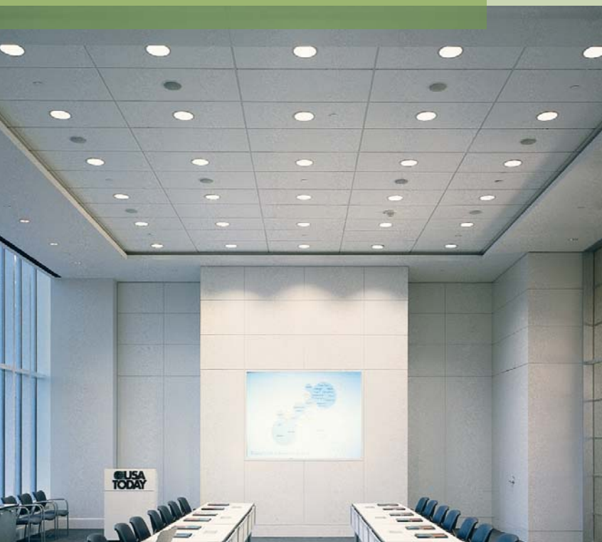
Ultima Open Plan com perfil SUPRAFINE tipo "T" de 9/16"
